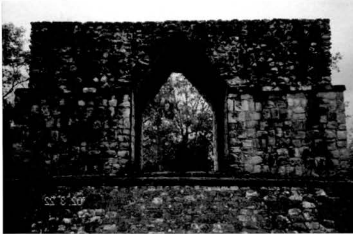
Figura 1. Arco en la entrada principal de Ek' Balam.
