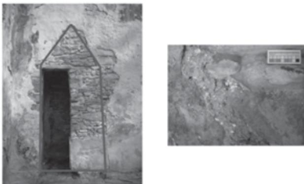
FIGURA 4. Modificaciones (muros añadidos) en la fachada principal del Templo de la Cruz Foliada (izq.). Detalle de materiales arcillosos con nódulos de cal sin mezclar (der.)
