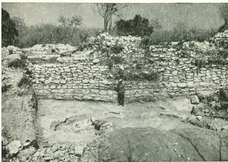
FIG. 8 c. Dzibilchaltún. Mampostería del Período "Formativo". Muro de terraza hecho de bloques ligeramente labrados. Período III. Estructura 500.
