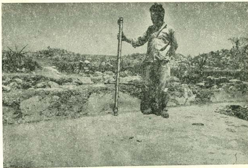
FIG. 8 a. Dzibilchaltún. Mampostería del Período "Formativo". Muro de lodo compacto con acabado de estuco. Período I. Estructura 605.
