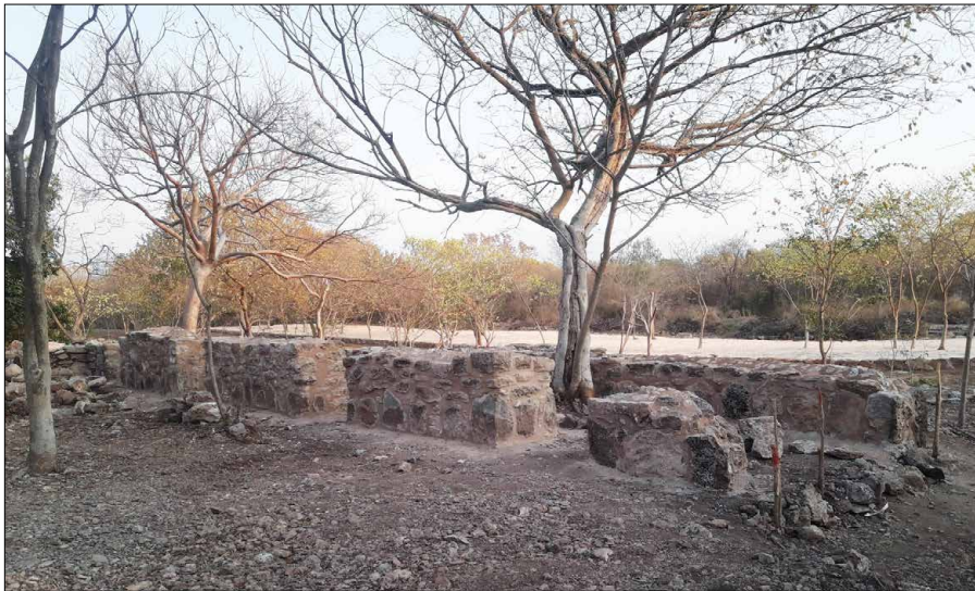
Figura 15. Vista de los accesos restaurados del muro Norte de la Estructura S6B.
